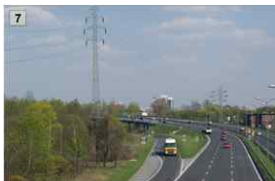
Ryc. 51 - Fotografia - Widok na wiadukt drogowy DTS - autor: Piotr Zabłocki
